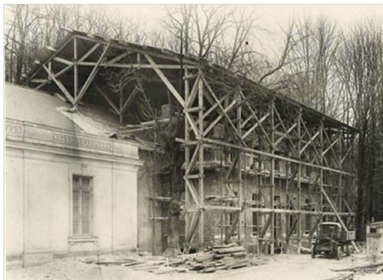
Construction du Nouvel Observatoire en 1929 © BIPM
