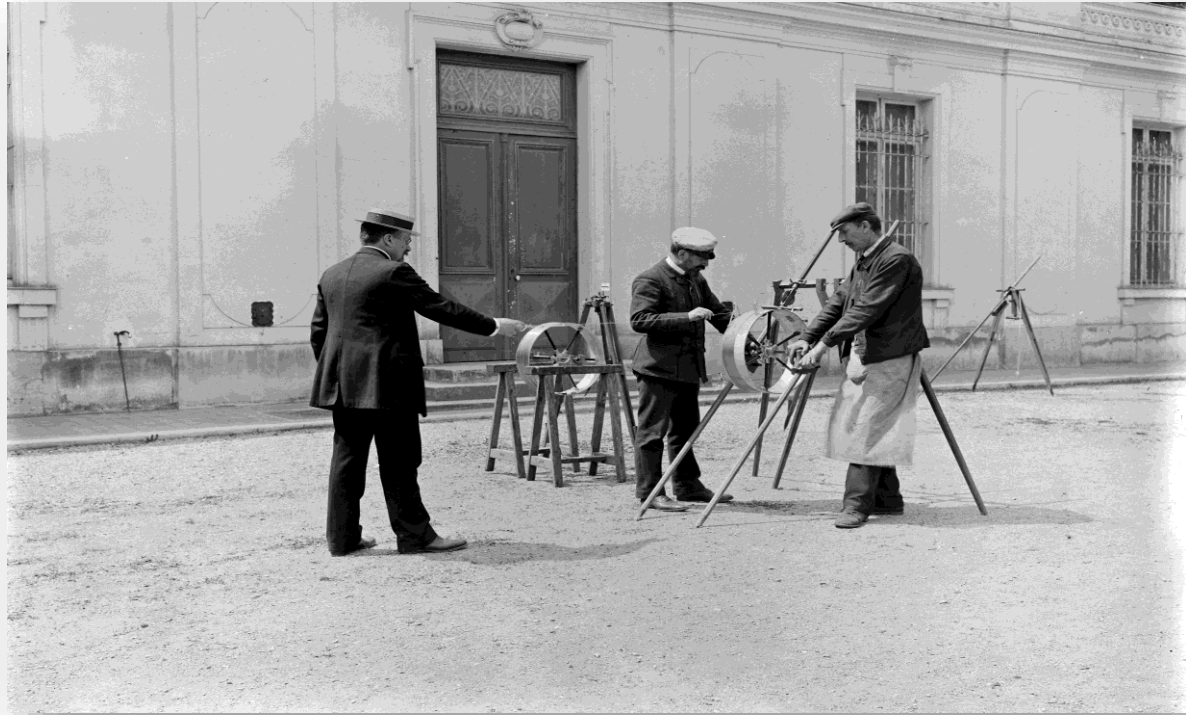
1907, Guillaume effectue des mesures avec l'appareil de Jäderin amélioré et des fils d'invar dans la cour du Bureau international (© Jacques Boyer_Roger-Viollet)
