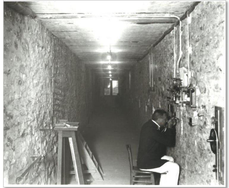
Charles-Édouard Guillaume effectuant des mesures dans la base géodésique d'une longueur de 24 m, installée dans le sous-sol de l'Observatoire.
